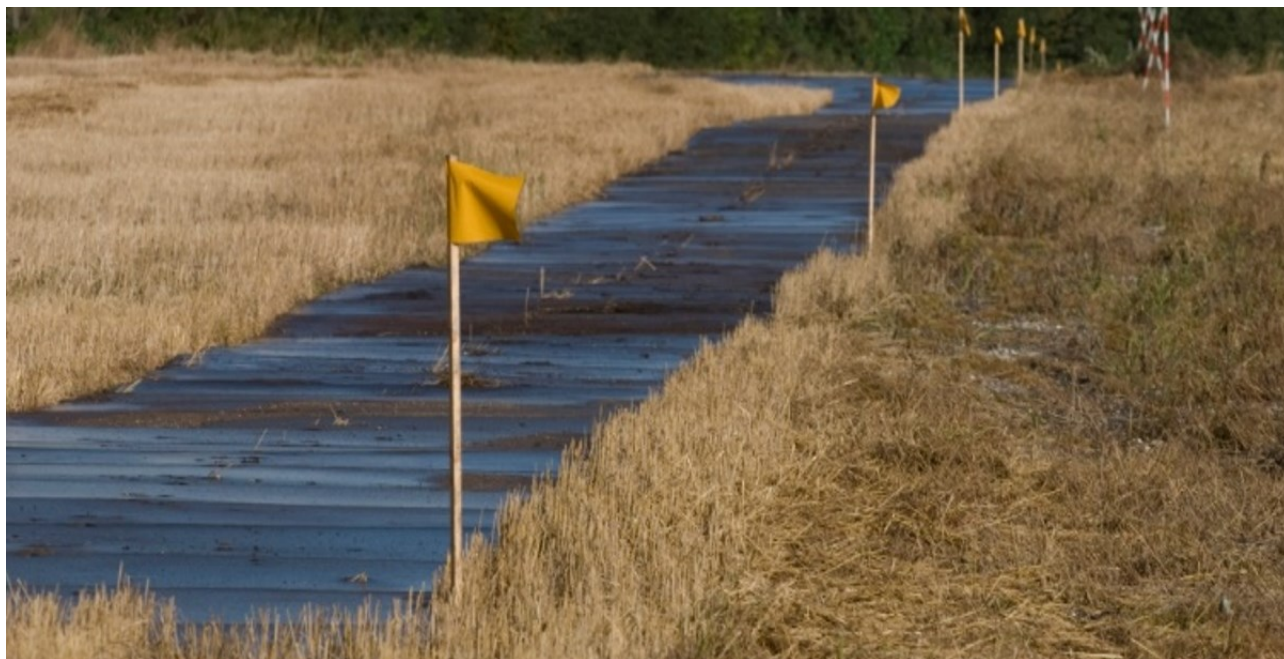
Figur 4.15 adgangsvej med køreplader
