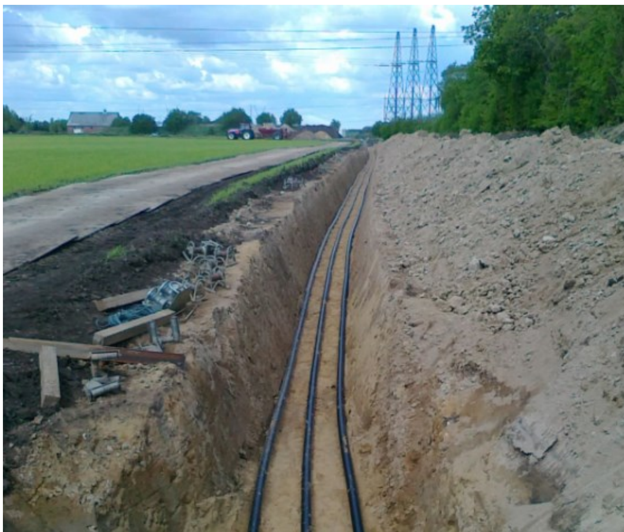
Figur 4.9 Kabelanlæg lagt ud i åben grav
