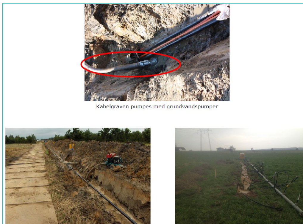
Figur 3.4 Forskellige metoder til at holde kabelgraven tør. På billedet til venstre etableres drænrør, til højre et sugespidsanlæg.
