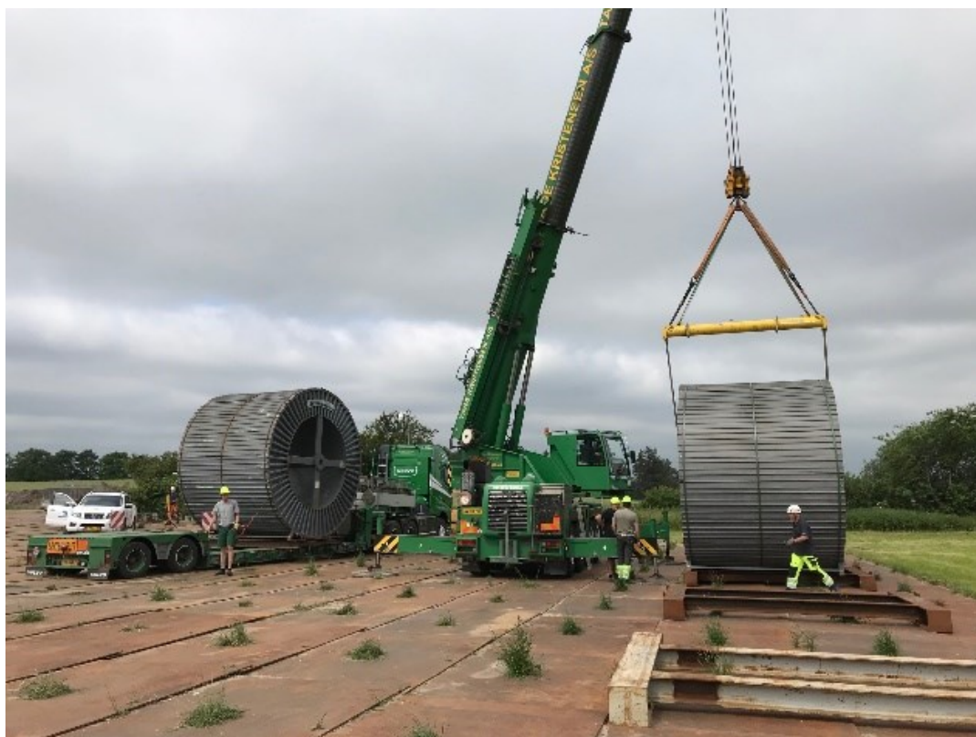
Figur 4.13 Håndtering af kabeltromler på tromleplads
