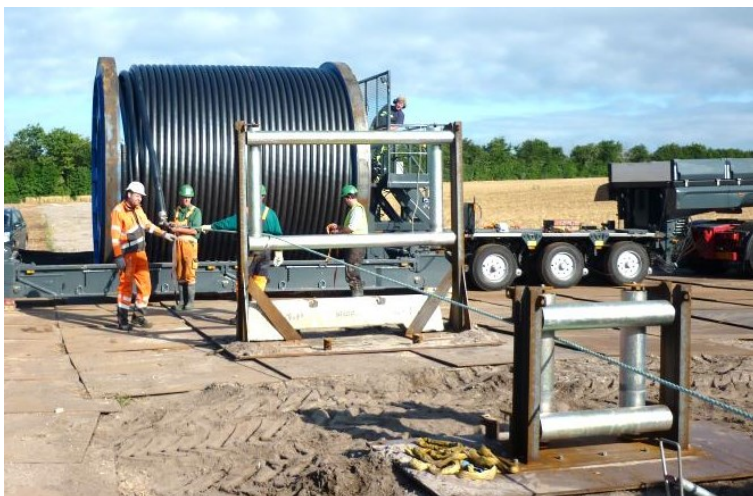
Figur 4.19 Kabeltromle på blokvogn
